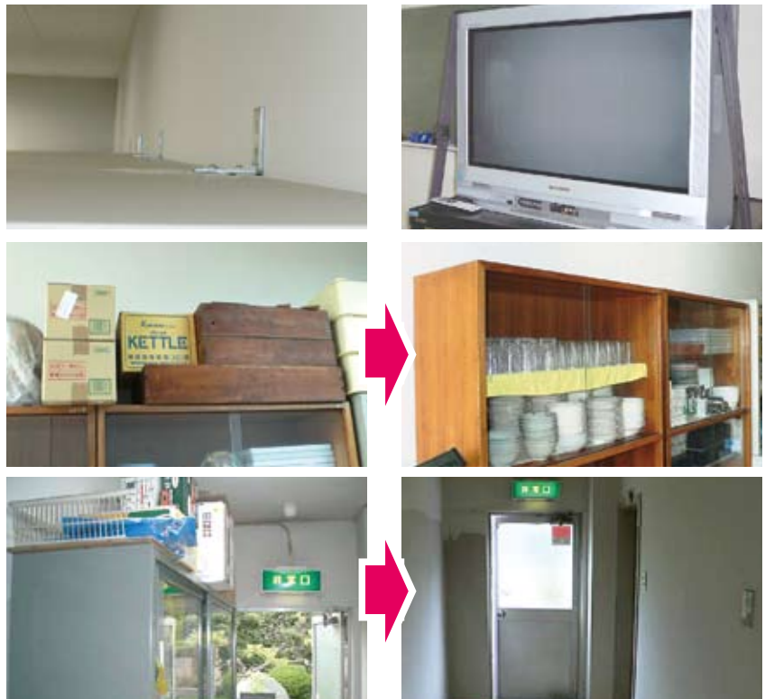
(図2) 地震時の減災のための改善措置の例 背の高い什器類のL字金具による倒壊防止措置(左上)、テレビの落下防止措置(右上)、背の高い什器類の天井上に置かれた物品の撤去【改善前(左中)と改善後(右中)】、緊急避難路に置かれた物品の撤去【改善前(左下)と改善後(右下)】
